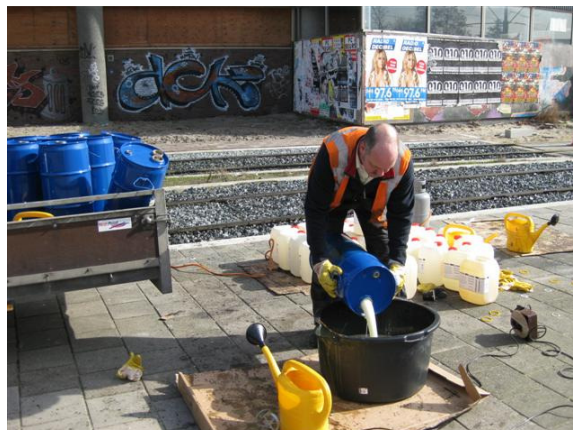
2 – Etter oppvarming tømmes PUR i et blanderkar.
