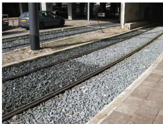
6 – Sluttresultat: forsterket pukklag.
